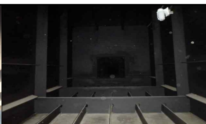
Steel Box Girder(내부) 전경
