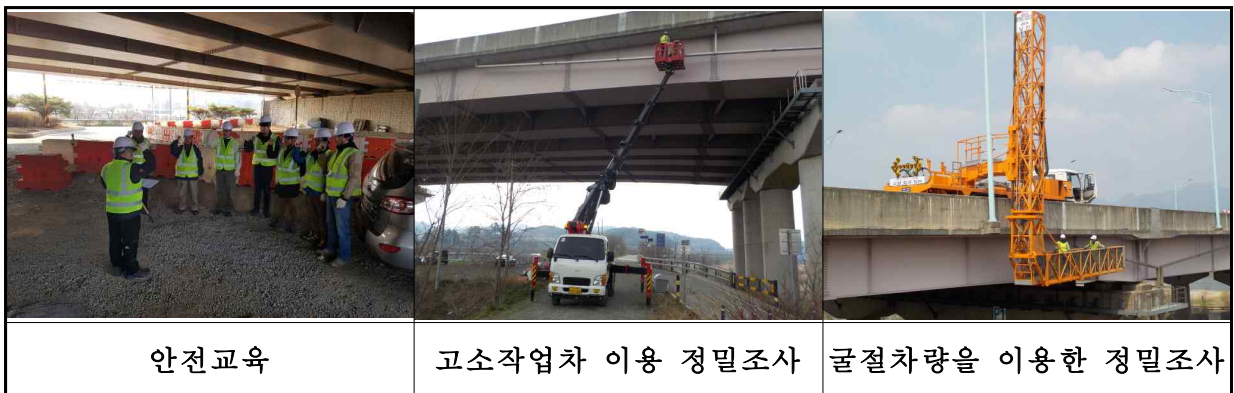
<사진 2.1.2> 외관조사 현황
