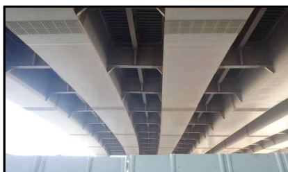
Steel Box Girder(외부) 전경
