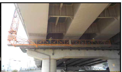
고소점검차 이용 점검현황
